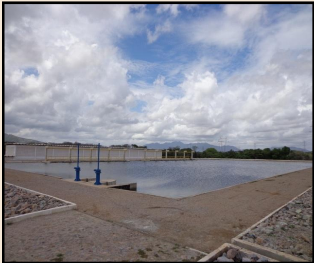
Reservatório Apoiado com capacidade de 15.000 m 3 (Estação Elevatória – E.E 01).
