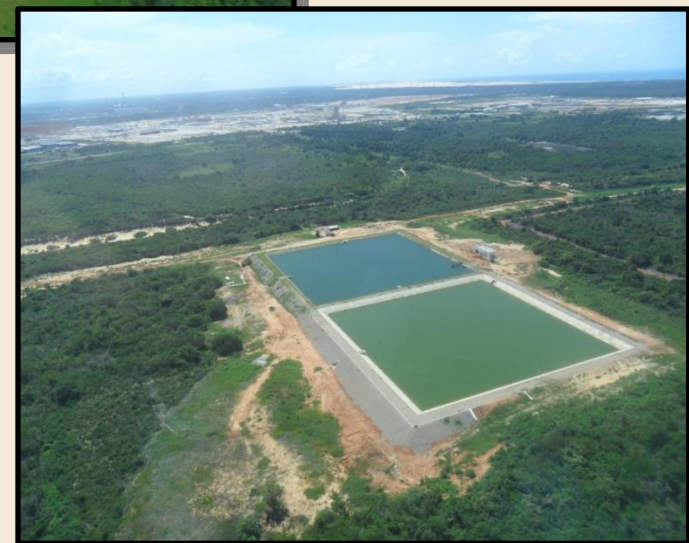
RESERVATÓRIO R3 NO PECÉM
