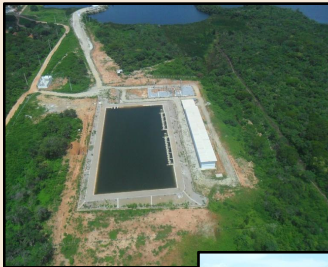
ESTAÇÃO ELEVATÓRIA EE1 E RESERVATÓRIO R1
